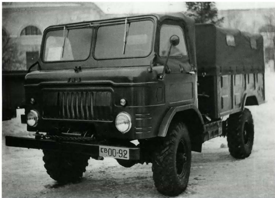
Опытный образец грузовика ГАЗ-62А (с лебедкой). Борты кузова усилены подштамповками
